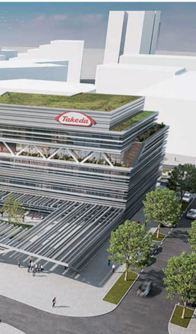
Forschung. Der Spatenstich für Takeda soll im Herbst 2023 erfolgen.
